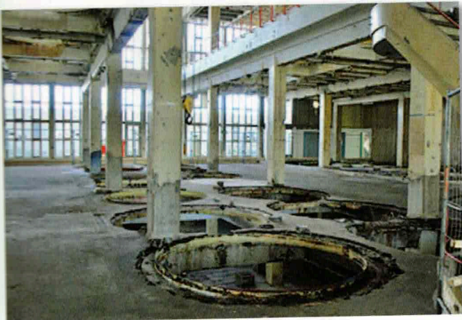
Der entkernte Bau K90 im März 2017.
